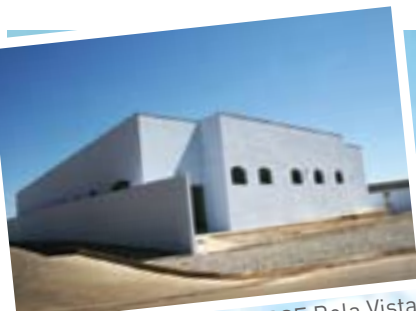
Futuras instalações do PSF Bela Vista.
